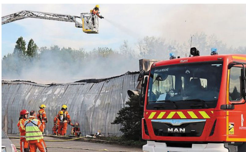
Un bâtiment de 300 m 2 abritant une entreprise de peinture et le local de stockage d'une entreprise d'ébénisterie a été détruit.
